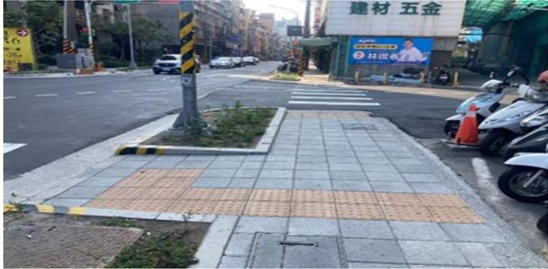
提供市民更安全、平整之通行空間，改善長江路 2 段至 3 段人行步道系統，人行道採用統一樣式色磚及無障礙化妝蓋板型式，人行道與設施帶分隔配色，簡單且具縱向引導性，化妝蓋板可避免女性用路人鞋跟、嬰兒推車及輪椅車輪卡在溝蓋之情事，提升通行安全。納入自行車共道，提供安全、便利的人車共道環境。
